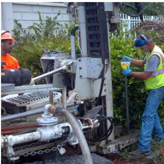
Instalación un pozo de inyección para limpieza de aguas subterráneas en el sitio Flash Cleaners.
