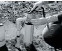
Tome el galón de cloro y el embudo (si es necesario) y eche cuidadosamente el cloro dentro del revestimiento del pozo.
