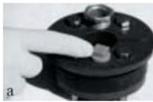
Determine qué tipo de pozo usted tiene y cómo echará el cloro al pozo. Algunos pozos tienen un sello sanitario con una válvula de aire o un tapón que puede ser removido. Si es un pozo perforado o cavado, la cubierta entera puede ser removida para brindar espacio para echar el cloro dentro del pozo.
