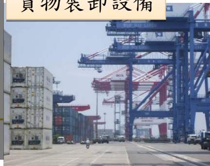
貨物裝卸設備
