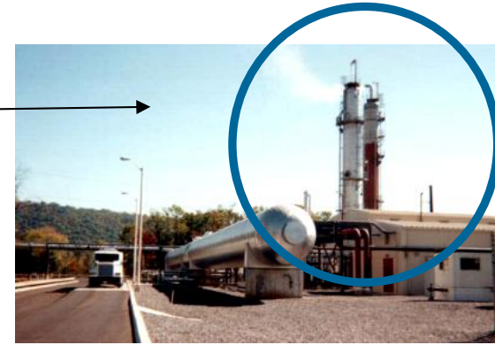
AES Cumberland ~ 10 MW
