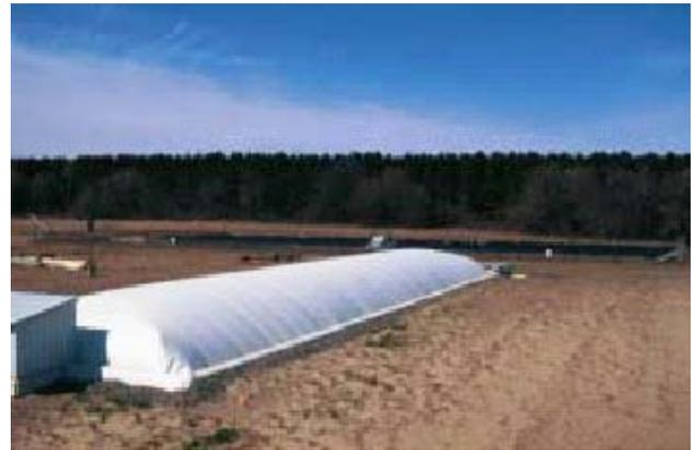
Figure C-9. 135 kW Dairy Manure Digester.<sup>5</sup>
