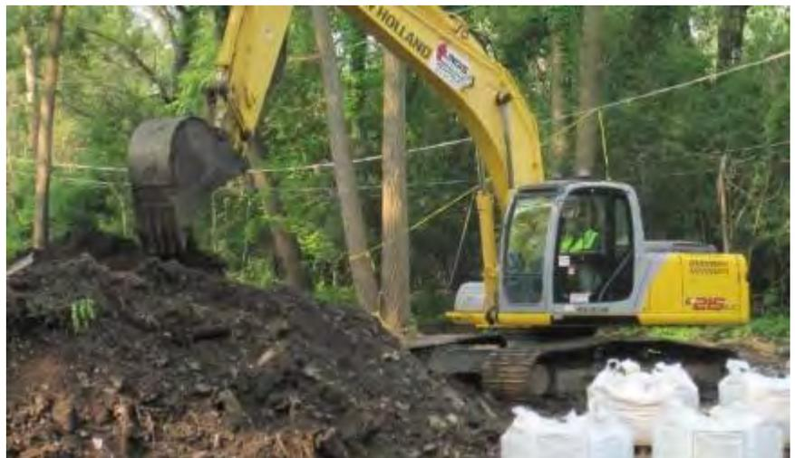
La EPA utilizará equipo como esta excavadora en la limpieza del sitio *Loewenthal Metals* este mes. Las bolsas blancas contienen material que se utiliza para el tratamiento del suelo contaminado antes de que se deseche en una instalación aprobada por la EPA.
