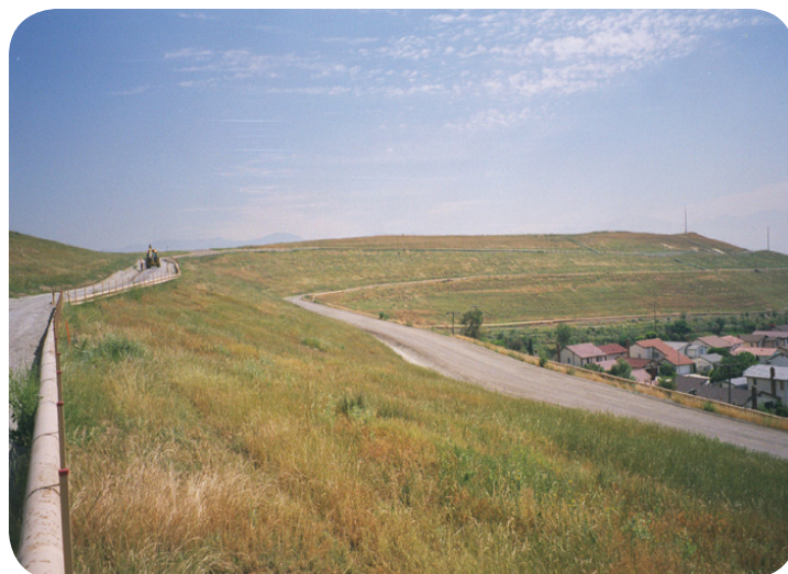
Ejemplo de cobertura de ET en el vertedero del sitio Superfund Operating Industries, Inc.
