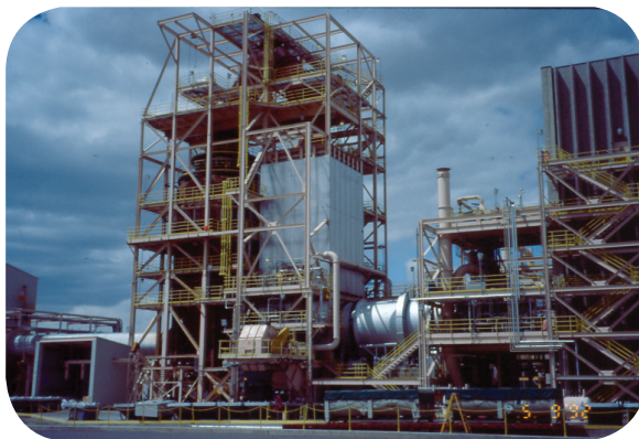
Ejemplo de un incinerador externo.
