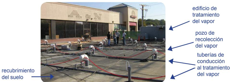
Con el sistema de ERH se limpia la tierra y las aguas subterráneas contaminadas.
