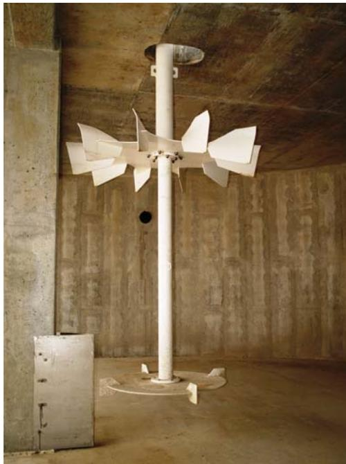
Figure 4-1. Eimco Water Technologies Carousel<sup>®</sup> System Excell<sup>®</sup> Aerator II
