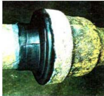
Junta da tubulação de ferro fundido
