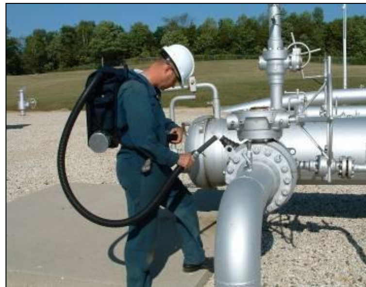
Измерение утечек с использованием пробоотборника большого объёма
