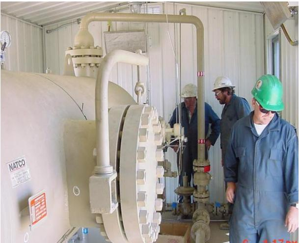
Передвижной трехфазный сепаратор, Источник: BP
