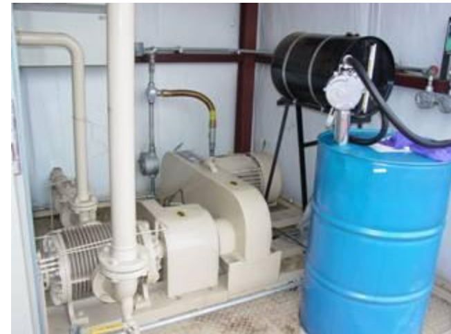
Baker, MT ConocoPhillips instalación de URV Fotos cortesía de Hy-bon Engineering
