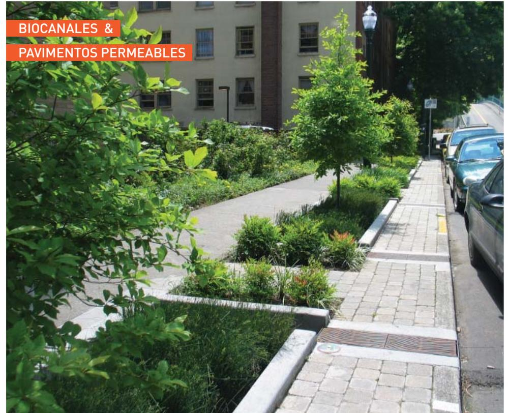
FIGURA 45 Calles verdes en Portland, Oregon. Los jardines de lluvia sirven a separar la acera de la calle. Biocanales y pavimento permeable también almanecen y limpian el agua pluvial antes de que entra el sistema de drenaje.
