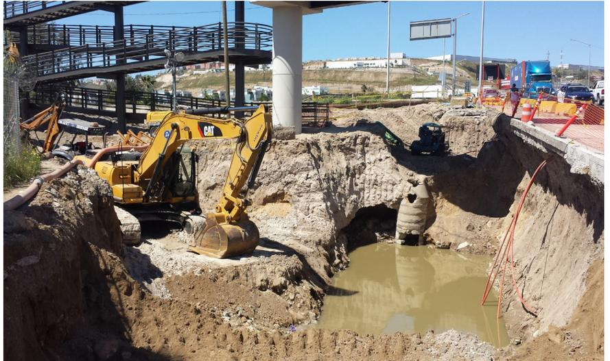
*Tubería de recolección de aguas residuales en reparación después de colapsar.
