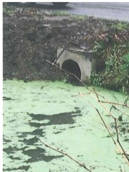
Mountainaire Overflow Conduit
