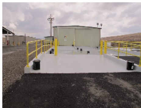
Edificio de almacenamiento de PCB en la instalación Kettleman Hills.
