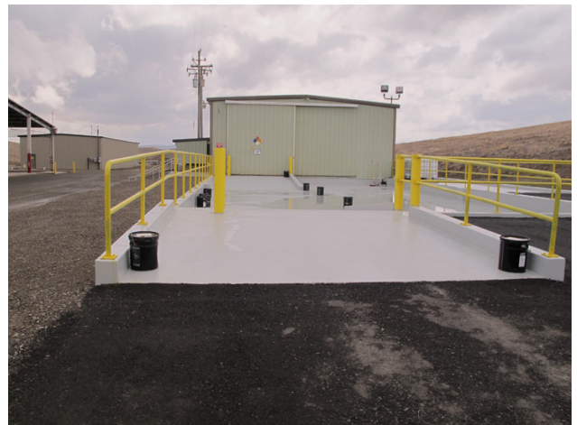
Edificio de almacenamiento de PCB en la instalación Kettleman Hills.
