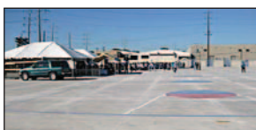
El predio de la instalación de Metales y Derivados está ya limpia y lista para ser reusada por los miembros de la comunidad en Tijuana.
