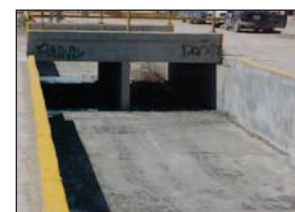
Sanamiento de Canal (Photo despues).
